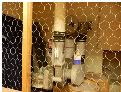
Väestönsuojan ilmanvaihtolaitteisto
